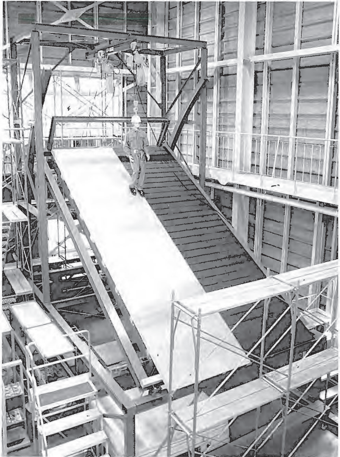
模擬屋根実験装置を用いた高所作業における墜落危険性に関する研究の実施状況（労働省特別研究）
