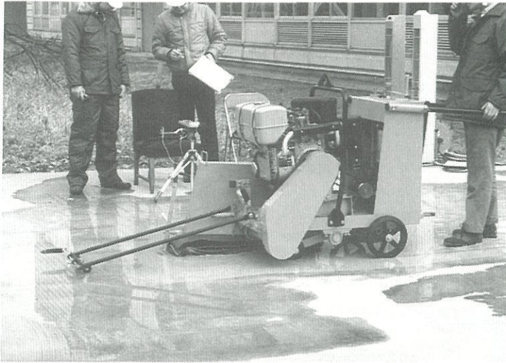
コンクリートカッターから発生する騒音測定
