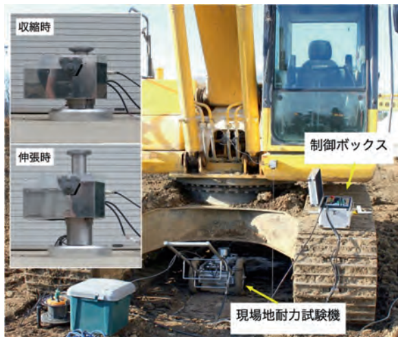
図 1 現場地耐力試験 (BCT) の概要
