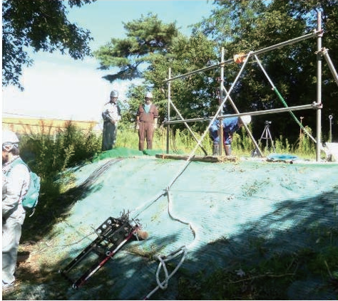
写真5 親網固定支持点の衝撃載荷試験
