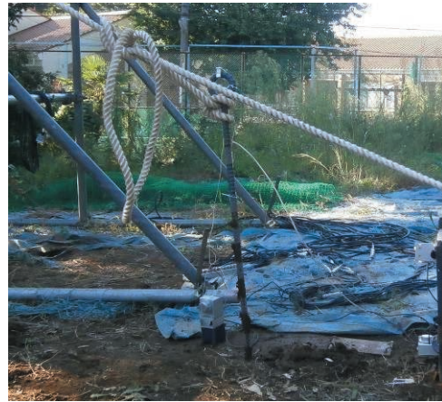
写真6 完全に引き抜けたアンカー(根入れ0.5m)
