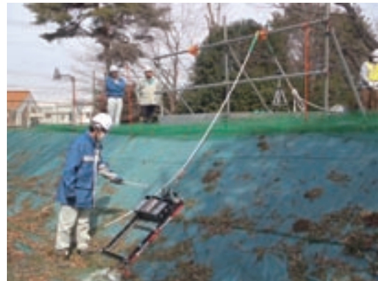
写真4 親綱固定支持点の衝撃載荷試験
