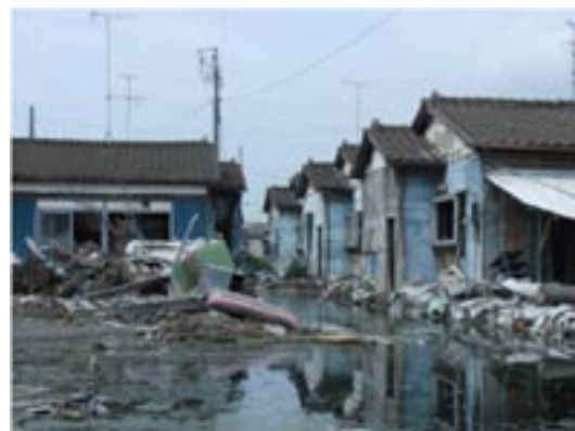
写真1 東日本大震災により被災した住宅の例
