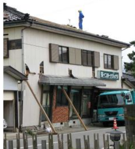
写真2 地震により被災した家屋の補強状況
