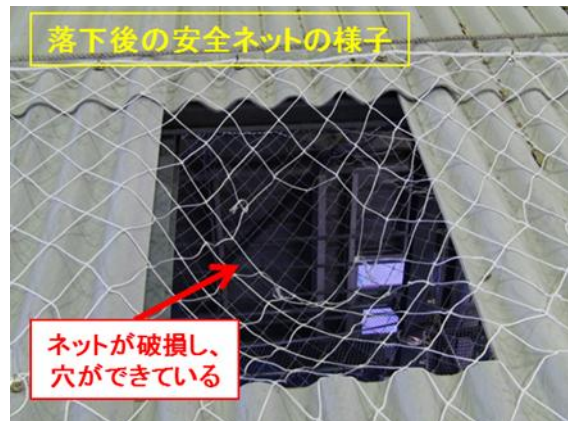
写真4 安全ネットによる強度試験の状況
