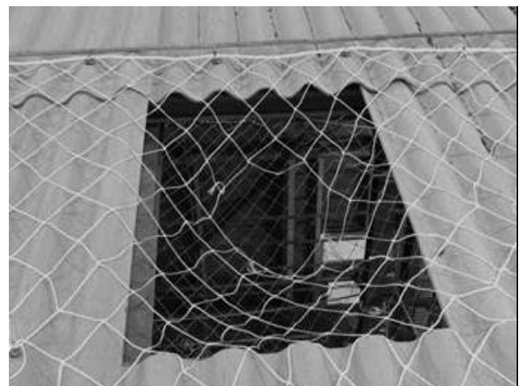
写真7 安全ネットによる踏抜き防止対策
