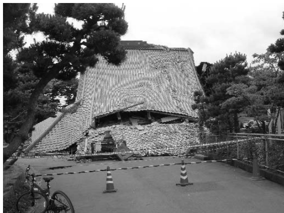
写真2 地震により被災し損傷を受けた家屋
