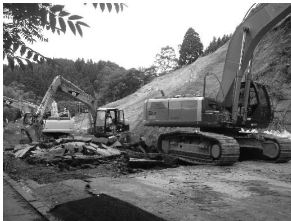
写真1 地震により崩壊した国道の応急復旧作業
