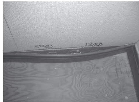
写真3 幅木が浮いた状況
