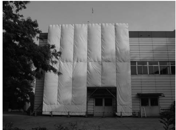
足場に作用する風荷重の実測調査の様子
