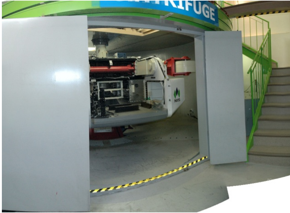
写真-2 ピット出入口扉
