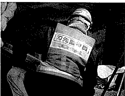
先行手掘り作業の監視人
