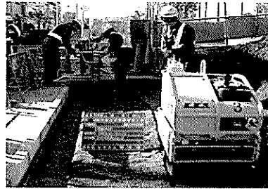
ローラーと作業員による締固め作業 (輻輳する作業は非常に危険)
