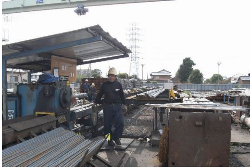
作業場所への屋根の設置
