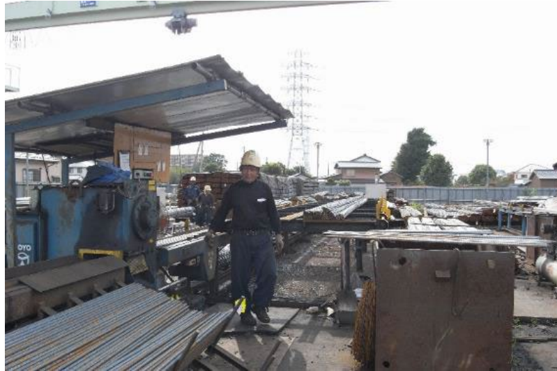
作業場所への屋根の設置
