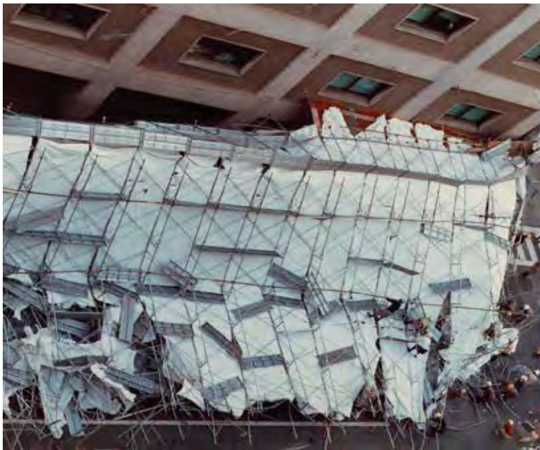
写真1 強風により倒壊した足場
