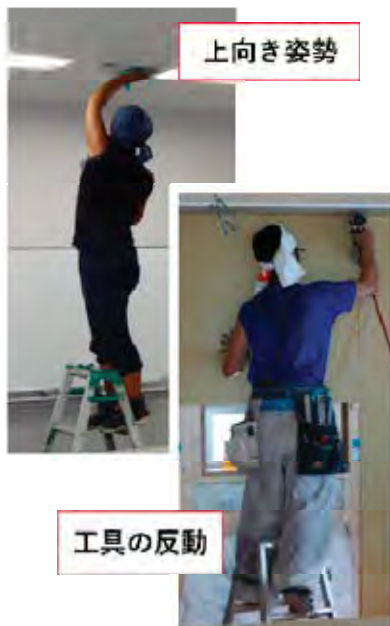
写真1 バランスを崩しやすい脚立作業の例
