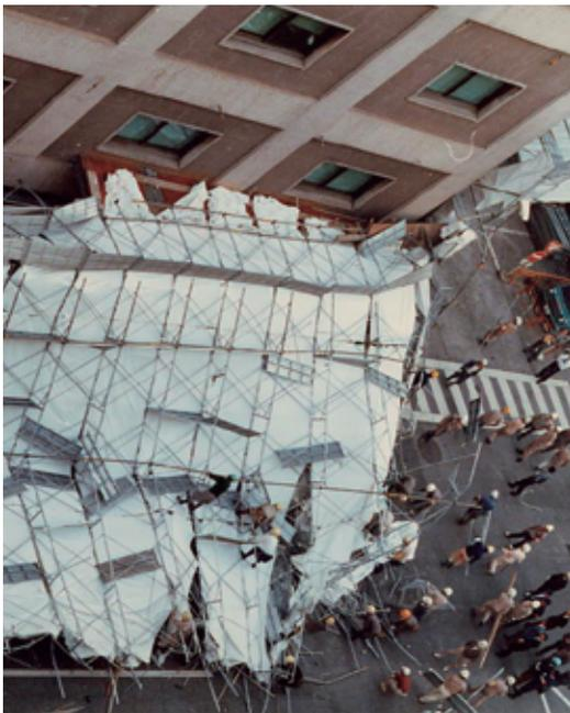
写真1 強風により倒壊した足場
