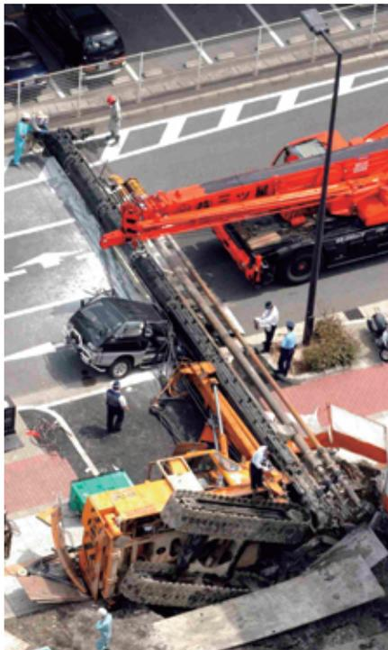
写真1 くい打機の転倒災害
